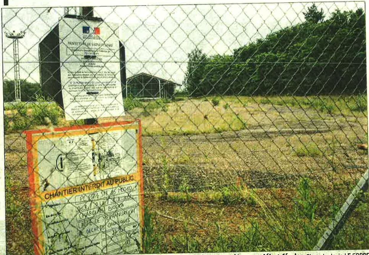
■ Le permis de construire pour le méthaniseur a été accepté par la préfecture début février. Photo Ludovic LE GORRE
