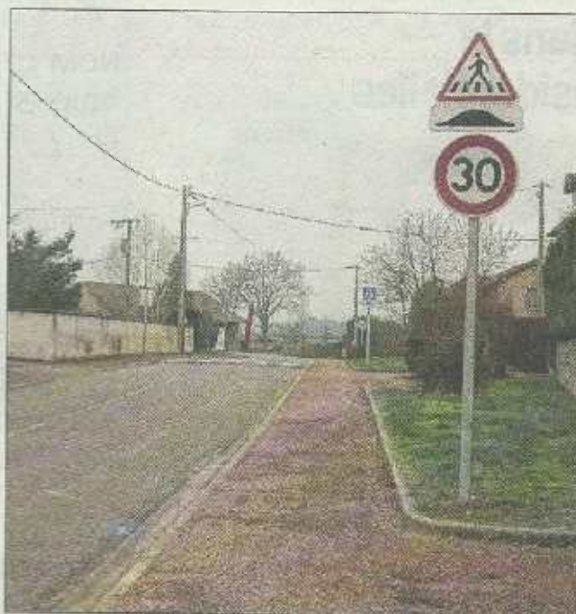
■ Des ralentisseurs et une nouvelle signalétique ont été réalisés en octobre sur la traversée des Carrés afin de limiter la vitesse jugée excessive. Ces travaux, d'un coût global d'environ 7 000 € HT, ont nécessité un déclassement de cette portion de route départementale en route communale. Photo Emmanuelle BERNARD
