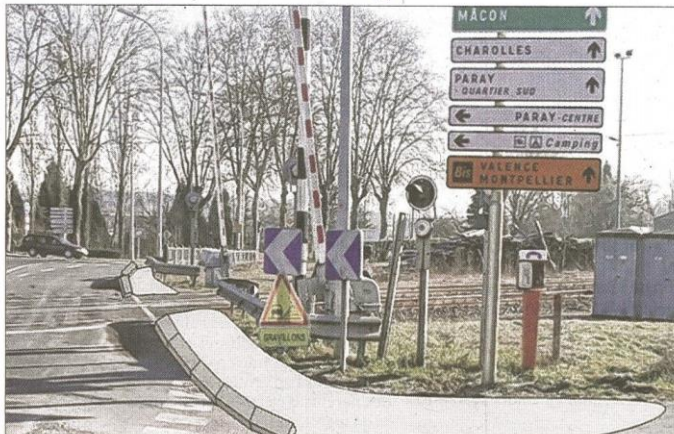
■ Le futur tracé de la Voie verte, matérialisé en gris, se situera vers le passage à niveau du lieu-dit Les Carrés, à Paray-le-Monial. Photo DR
